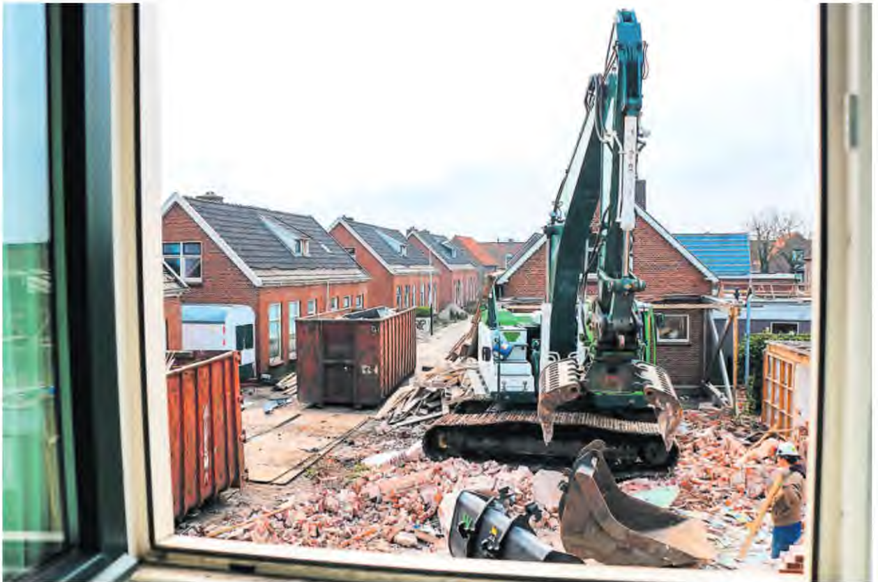
Het sloopwerk in Grou is begonnen. De foto is gemaakt vanuit de woning van de familie Veenstra, waar het paalrotprobleem met technische maatregelen kon worden opgelost. FOTO LC/ARODI BUITENWERF
