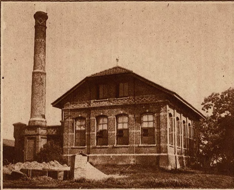
Het vroegere Pompstation aan de Pikmeer te Grouw, dat jarenlang de stad Leeuwarden van water heeft voorzien.
